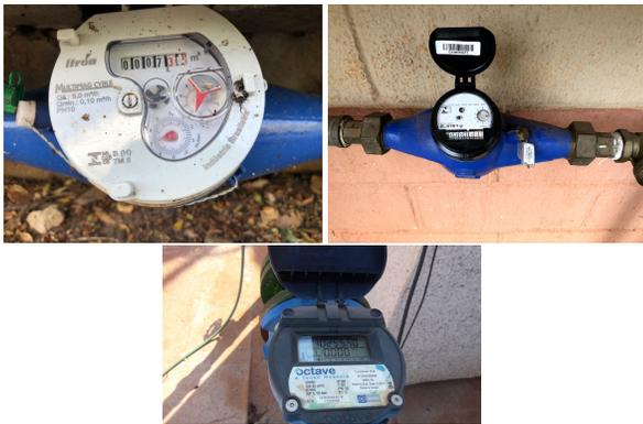
Figura 4. Tipos de Hidrômetros da UNICAMP. De cima para baixo Itron, Elster e Octave
